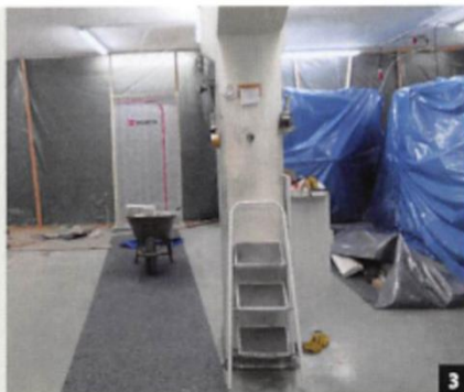
Abb. 3: ... wurden sie sorgfältig abgedeckt.
