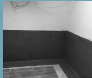
Kellerraum eines Wohnhauses
