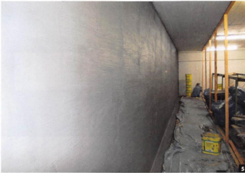
Abb. 5: Auf einen Spritzbewurf wurden anschließend ein Wassersperrputz und eine flexible Dichtschlämme aufgetragen.
