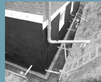
Einfamilienhaus in Neumünster
