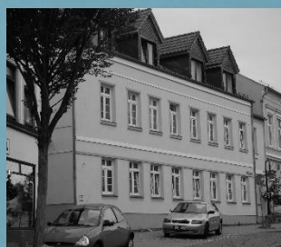
Wohnhaus in Flensburg
