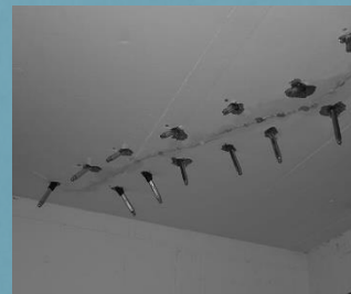
Kellerdecke in Kiel
