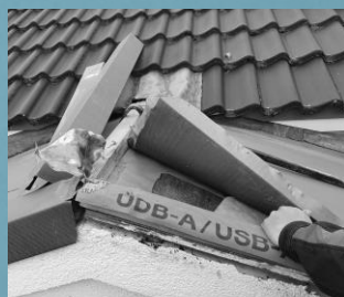
Dach eines Wohnhauses in Hamburg
