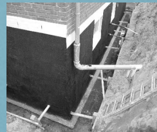
Einfamilienhaus in Neumünster
