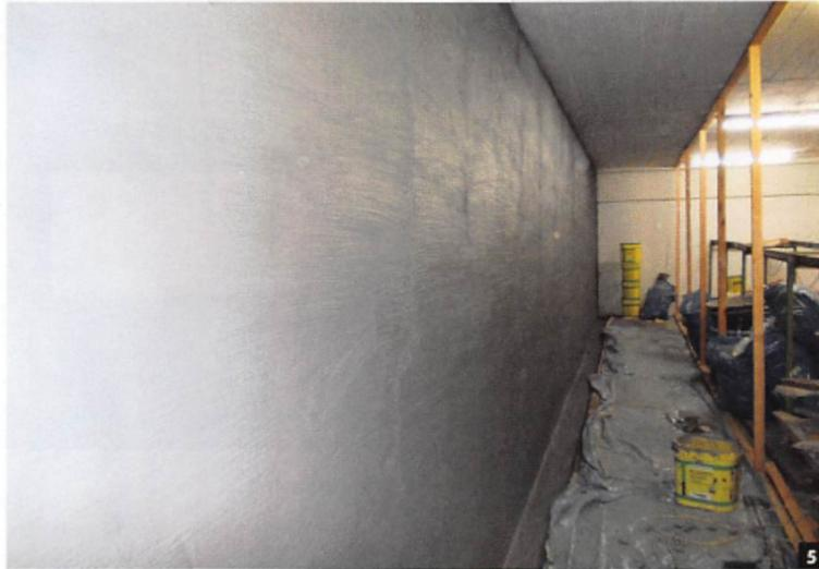
Abb. 5: Auf einen Spritzbewurf wurden anschließend ein Wassersperprutz und eine flexible Dichtschlämme aufgetragen.
