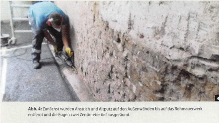
Abb. 4: Zunächst wurden Anstrich und Altputz auf den Außenwänden bis auf das Rohmauerwerk entfernt und die Fugen zwei Zentimeter tief ausgeräumt.
