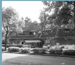
Geschäftshaus in Kiel
