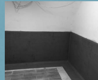
Kellerraum eines Wohnhauses
